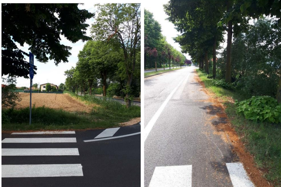
Viale Rimembranze dove è previsto l'accesso alla pista ciclo-pedonale e il completamento del marciapiede
