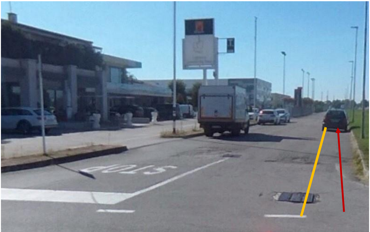
Tratto finale su sede stradale di via Leonardo da Vinci
